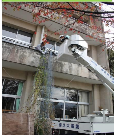
みどりのカーテン撤去作業
